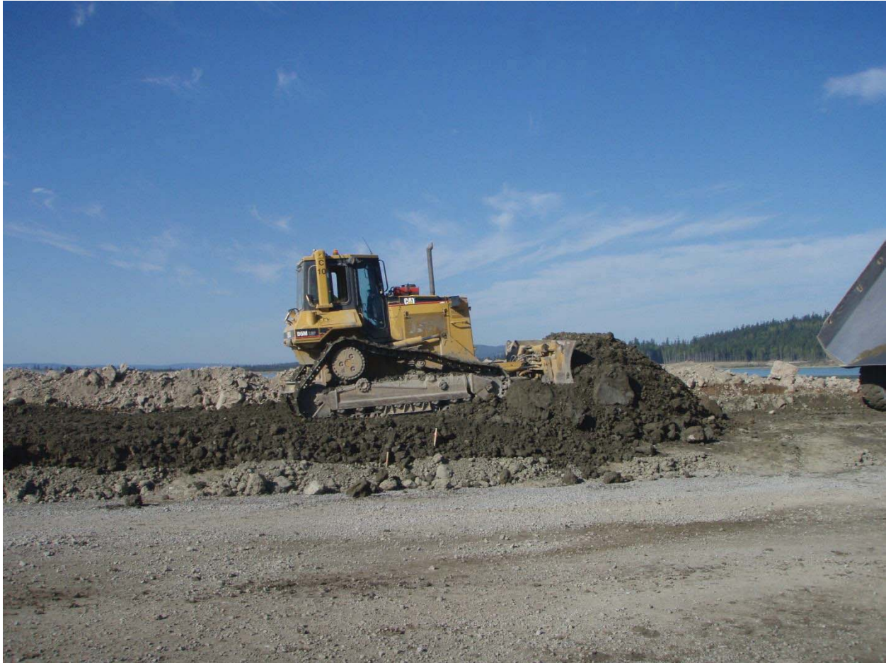
Dozer spreading till on PE
