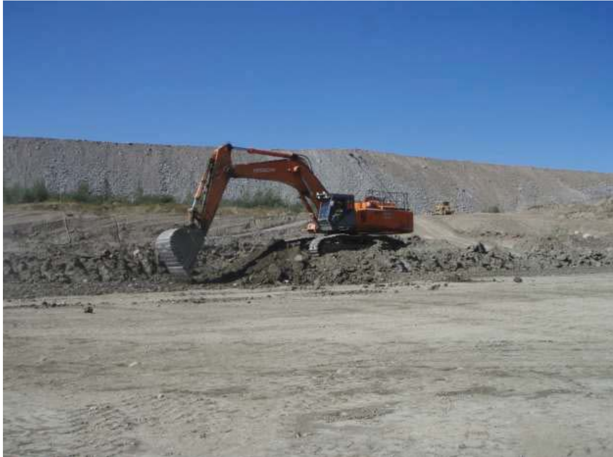
Hoe digging till in the Perimeter Borrow Pit
