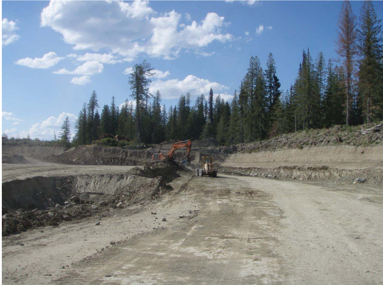
Hoe digging till in Perimeter Borrow Pit
