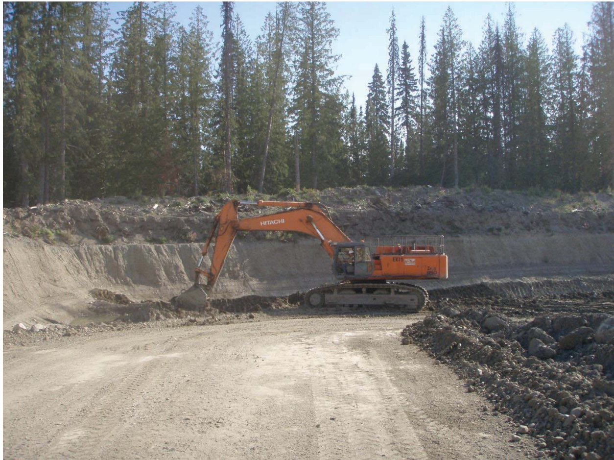
Hoe digging till in Perimeter borrow pit
