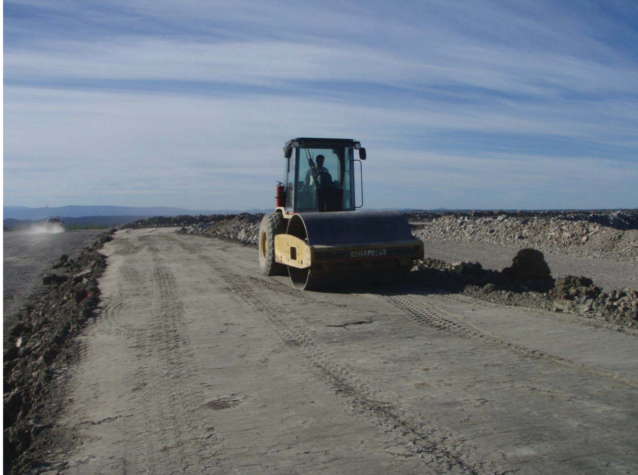
Roller compacting till on PE
