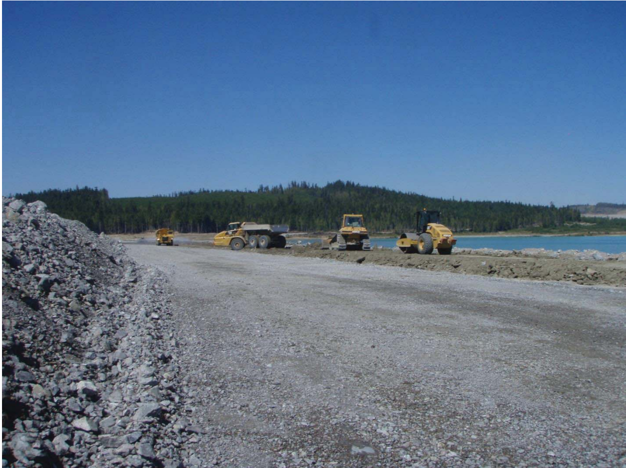
Dozer spreading till on SE (lift #8)
