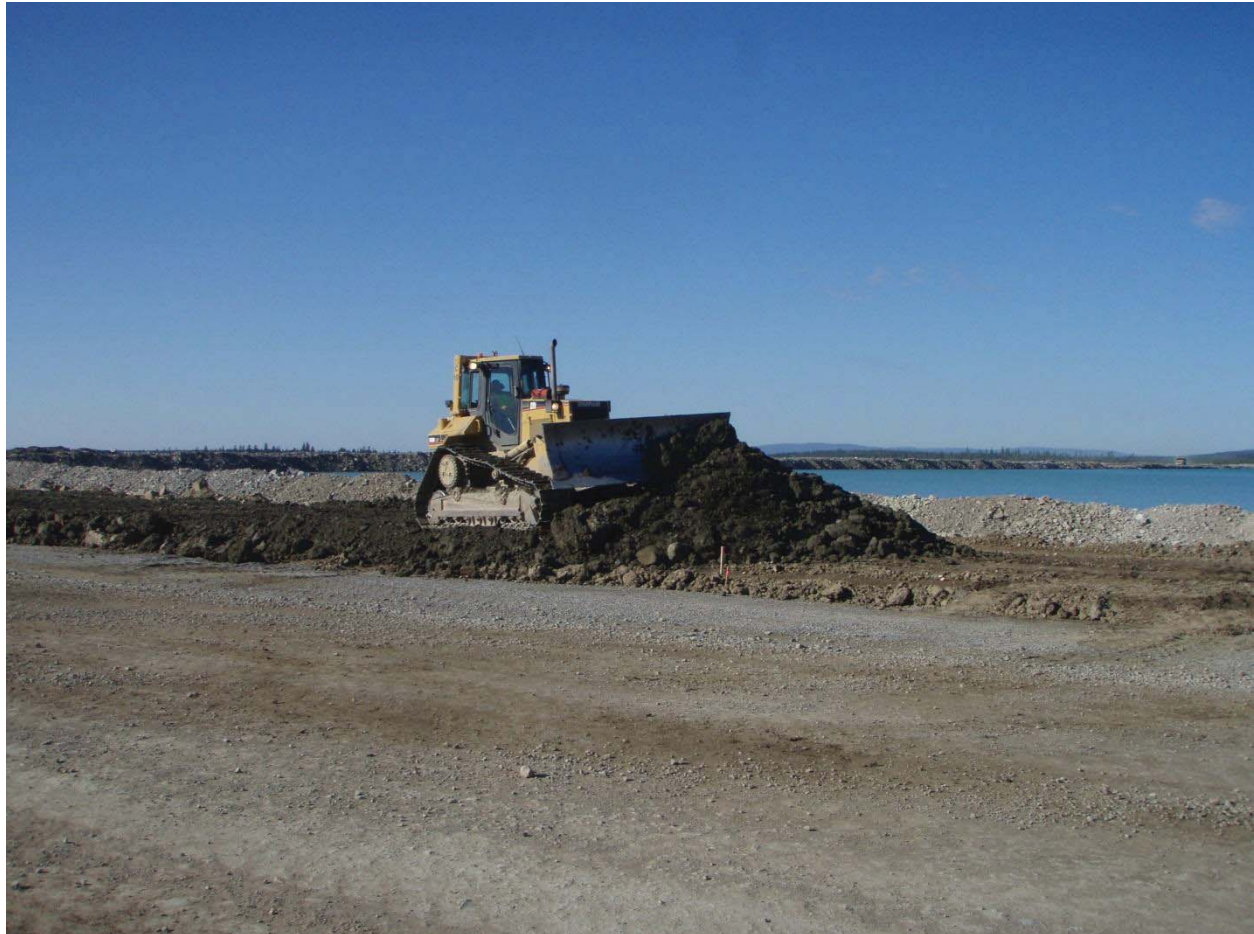
Dozer spreading till on PE
