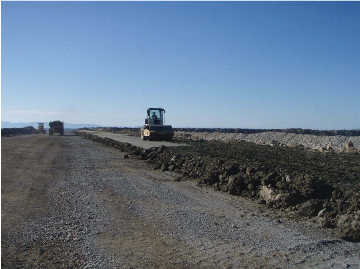
Roller compacting till on PE
