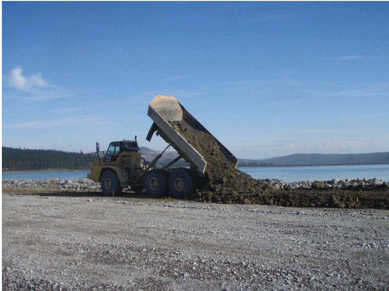
Wiggly placing till on SE (lift #7)
