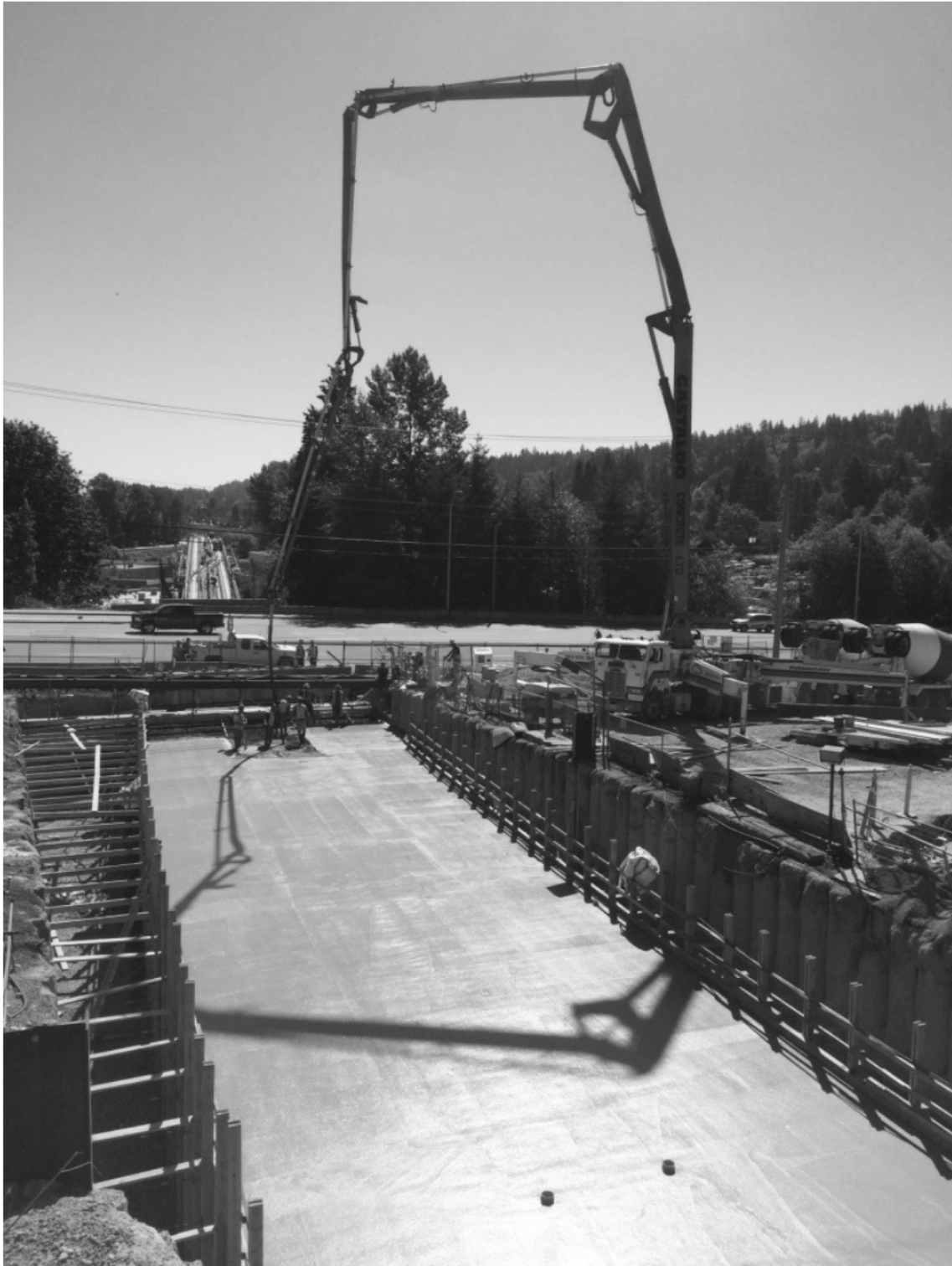
Figure 4 – North Portal Roof Slab Pour
